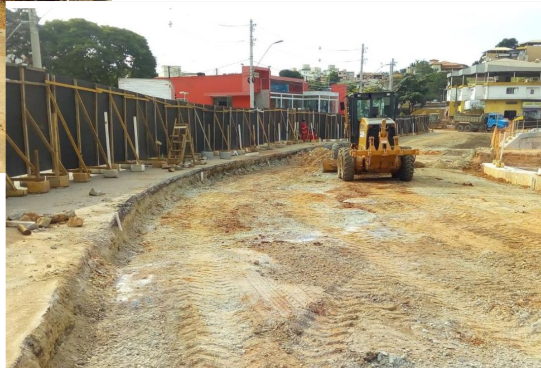
Terraplenagem - tratamento de camadas da pista de rolamento
